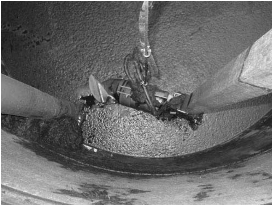
Bild 5. Blandningsbehållare och dess propelleromrörare. Foto: Mats Edström
